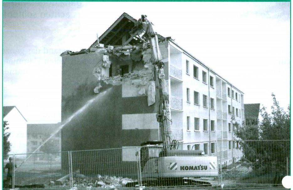
Abriss in der Willy-Muhle-Straße 9–13 und 15–21 im September 2004
